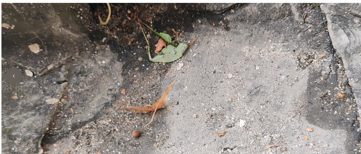
Фото . Главный фасад 3-й подъезд.
