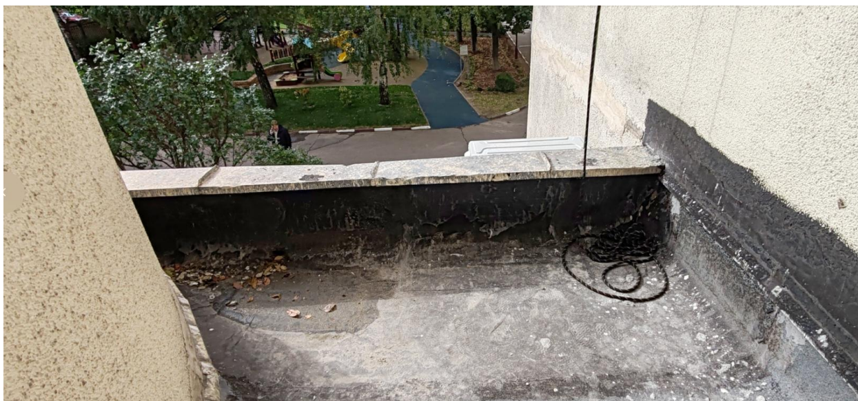
Фото . Дворовый фасад, 1-й подъезд, над входом в офис.
