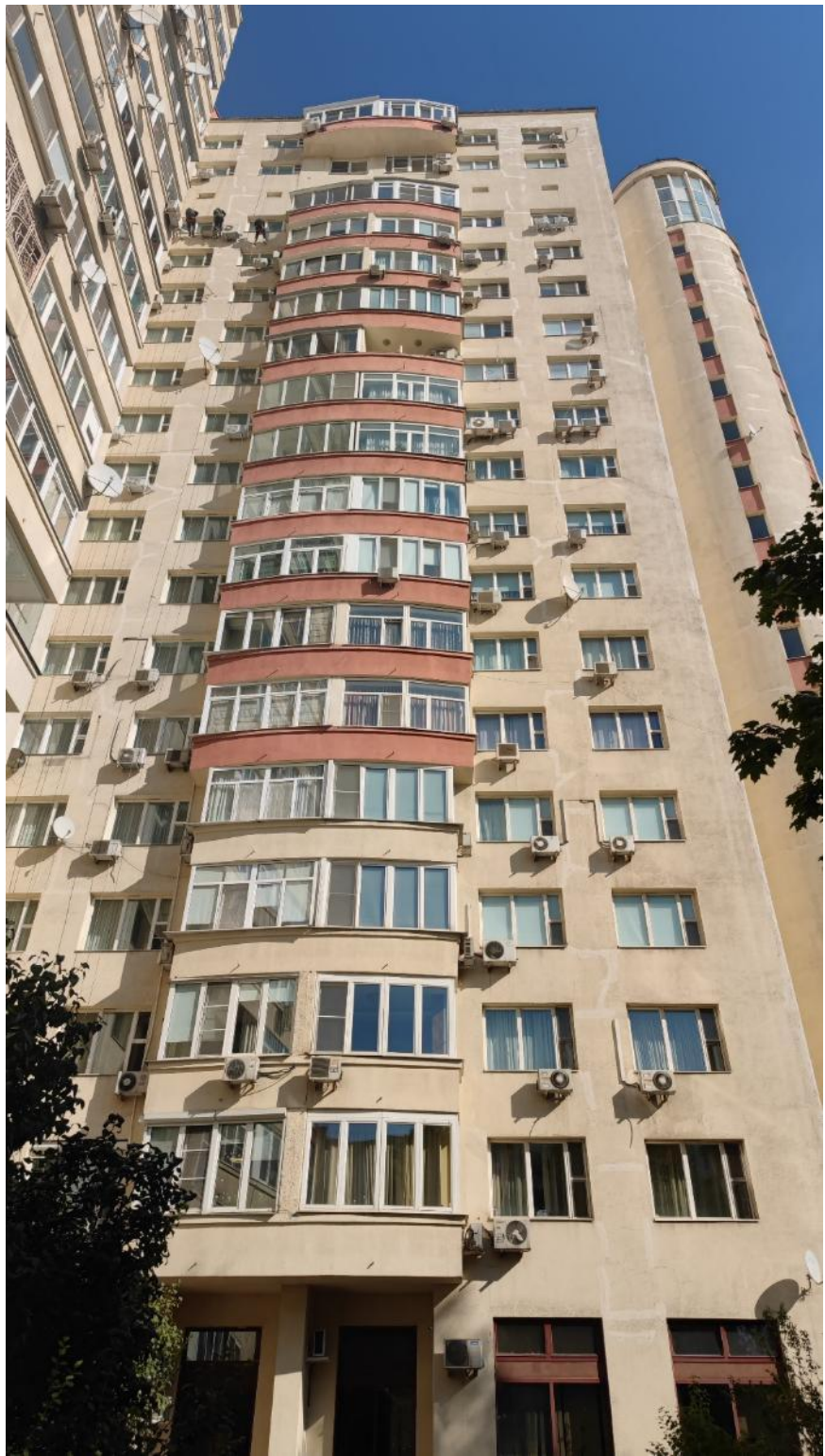
Фото 6 Фрагмент фасада со стороны двора.
