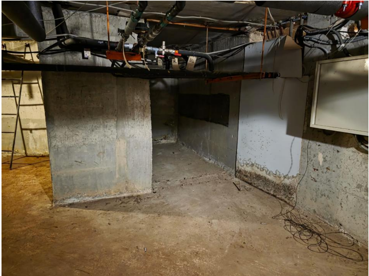
Фото 7 Помещения подвала. Общий вид.
