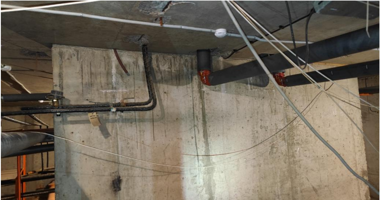
Фото 8 Помещения подвала. Общий вид.
