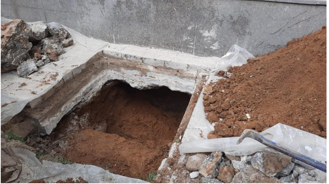
Фото 15 Вскрытие шурфа состорны двора
