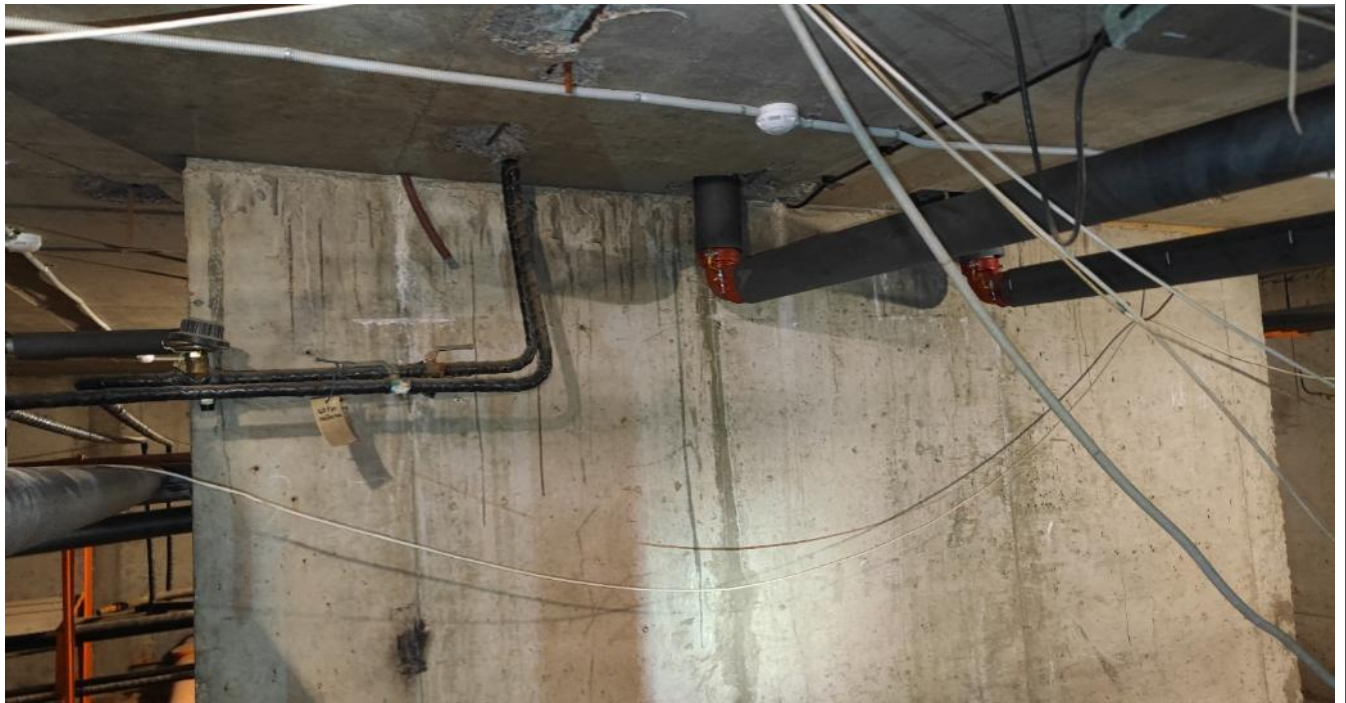
Фото 8 Помещения подвала. Общий вид.
