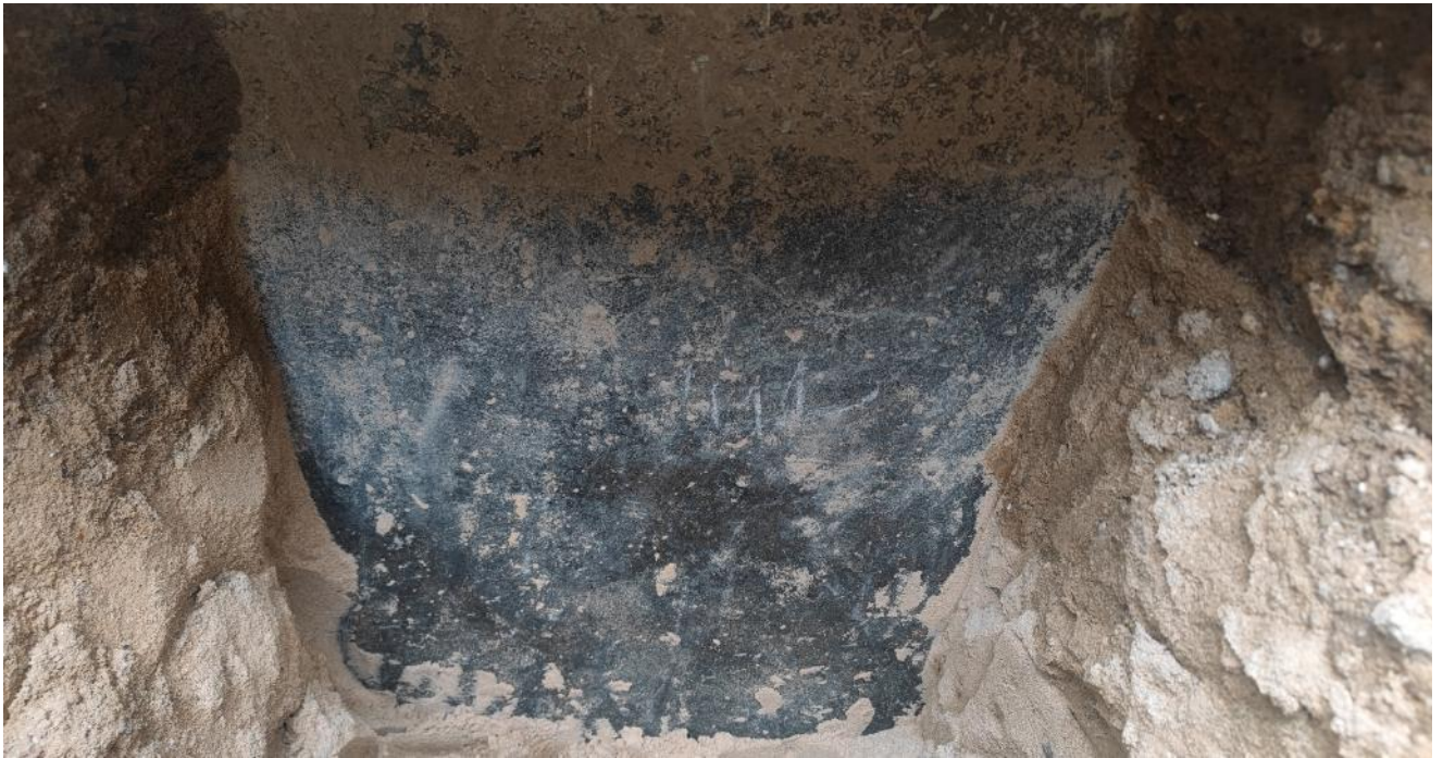
Фото 16 Вертикальная обмазочная гидроизоляция
