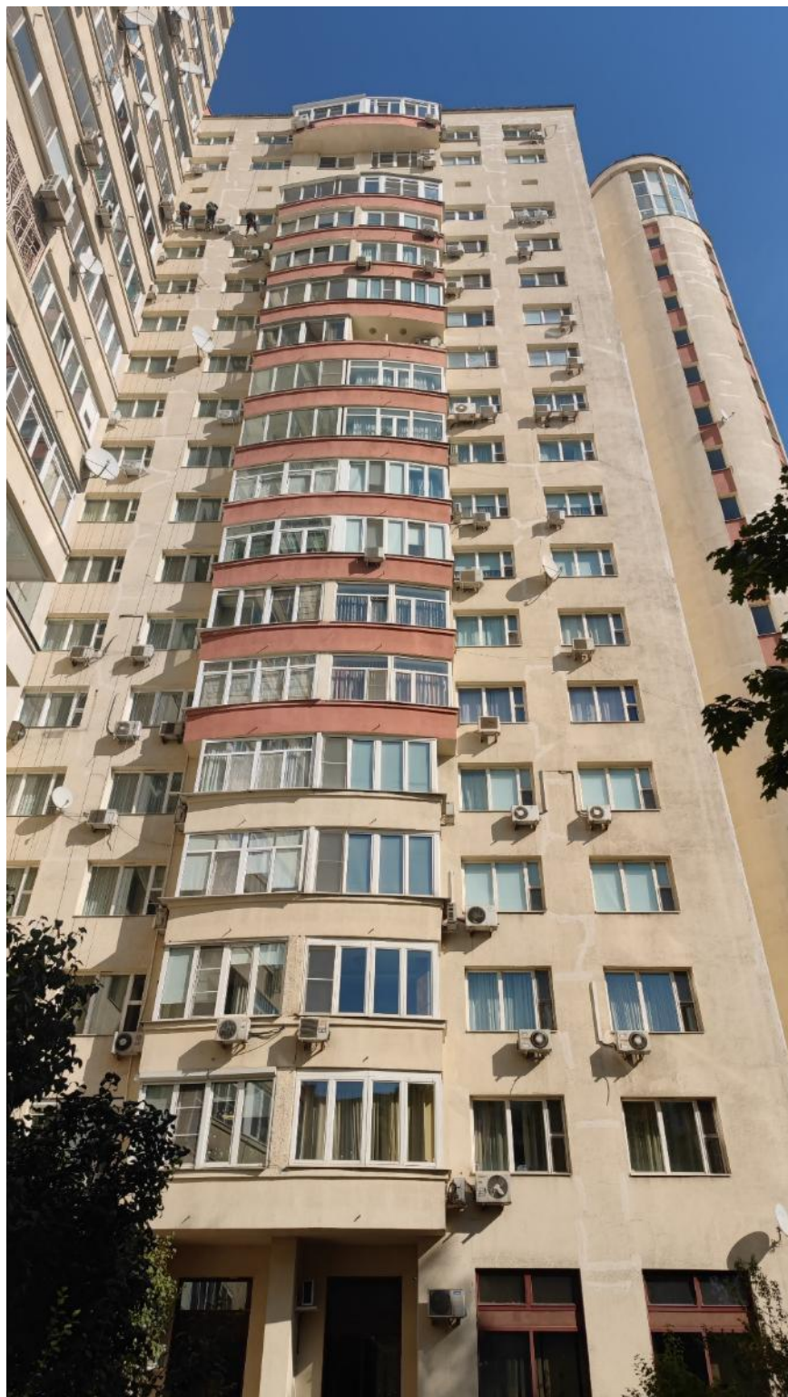
Фото 6 Фрагмент фасада со стороны двора.
