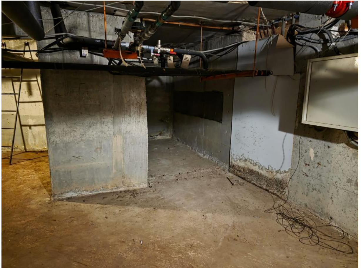
Фото 7 Помещения подвала. Общий вид.
