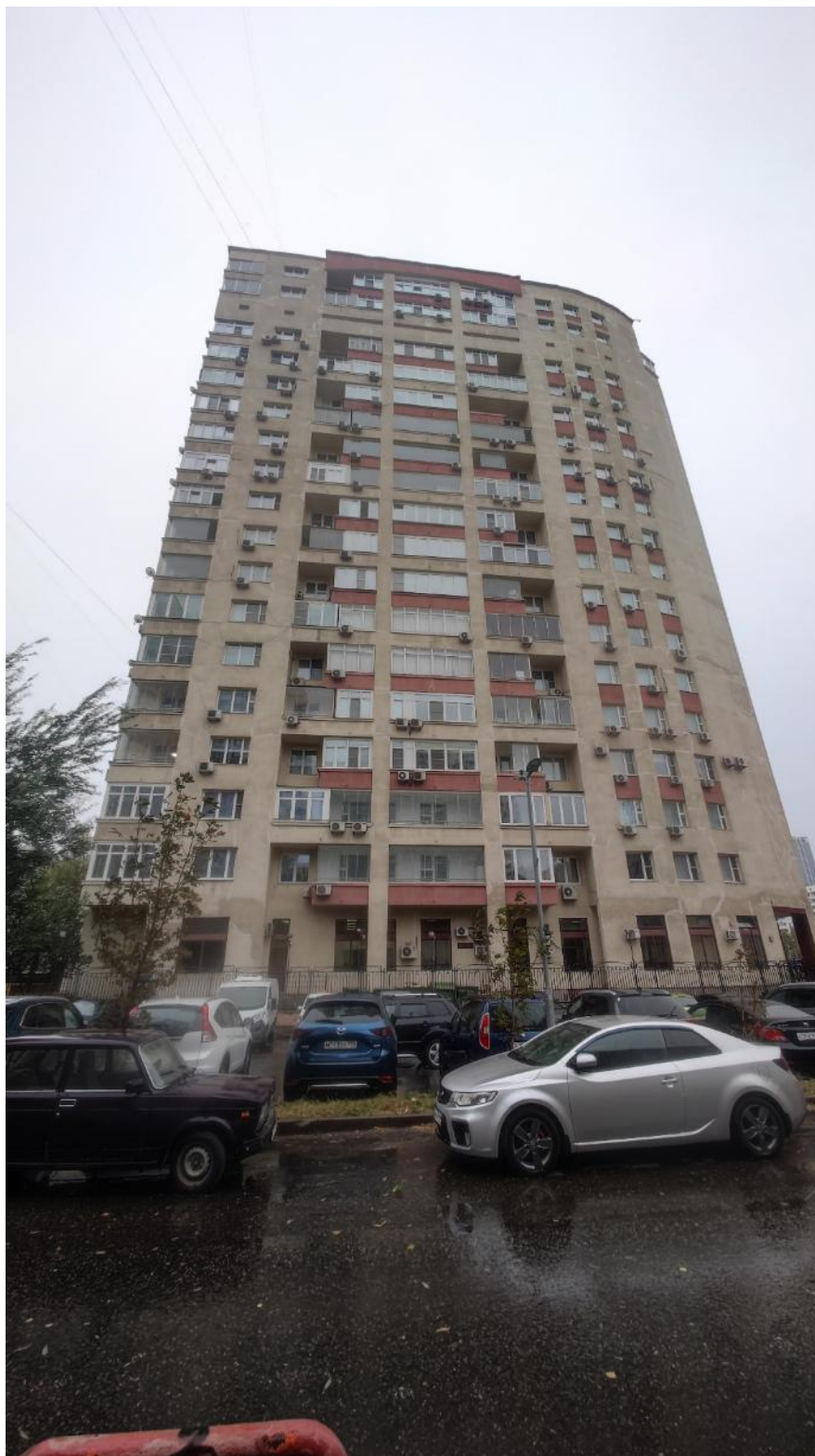
Фото 3 Фасад состороны проезда. Общий вид.
